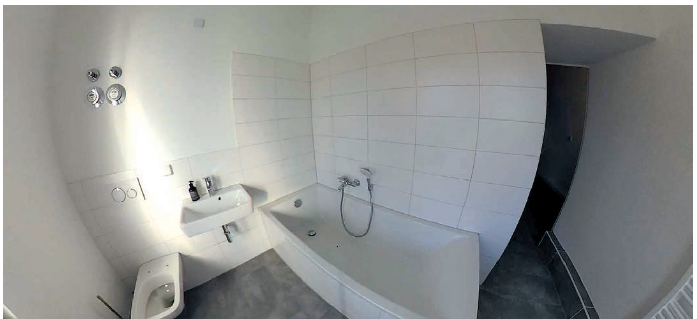
Nach umfangreicher Strangsanierung Komplettmodernisierung eines Bades
